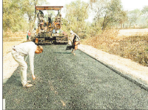
निर्माणाधीन सड़क और निरीक्षण में पहुंचे कलेक्टर।
